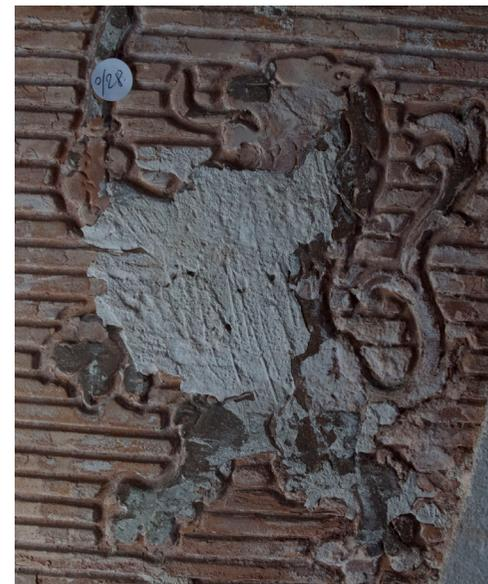
ICO 9247 - Résidu de l'enduit plâtre de recouvrement
